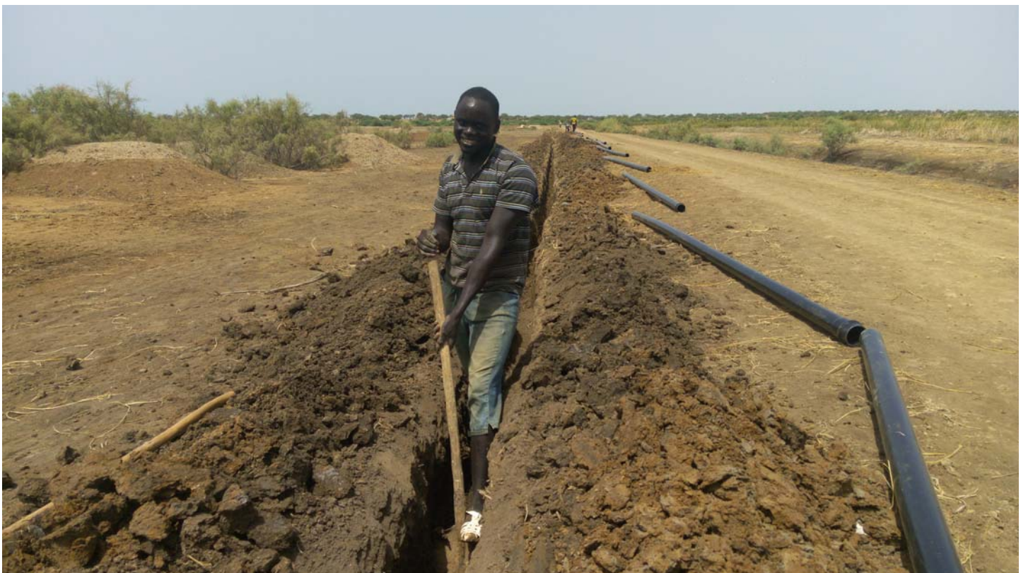
Extension réseau AEP Diagambal vers Polo
