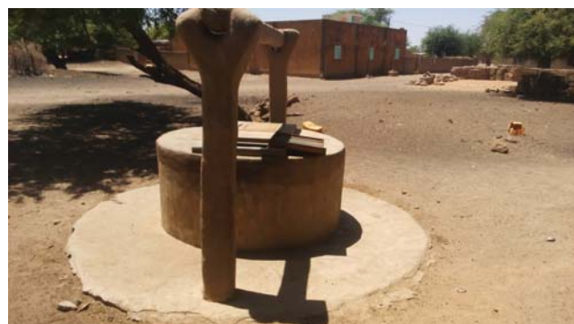
Puits à Soubalo Mboumba, Mery
