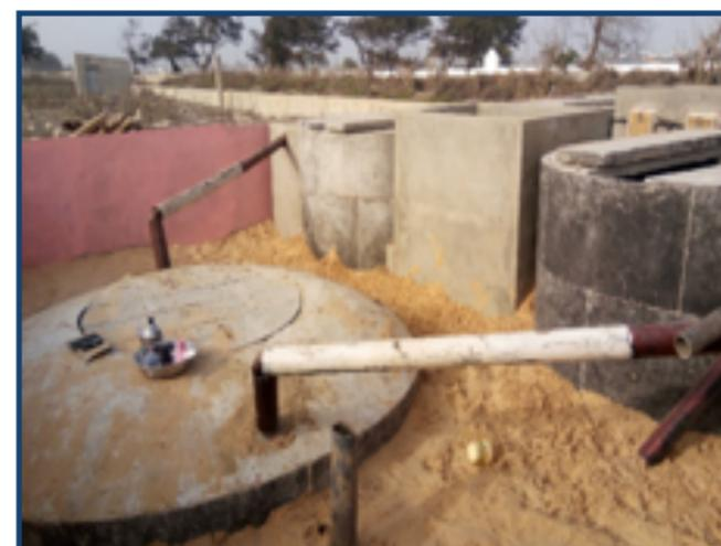
Installation d'une unité semi industrielle de biogaz pour les femmes transformatrices de Guet Ndar. Cette unité (modèle Puxin) a une capacité de production journalière de gaz qui varie entre 6 et 24 m<sup>3</sup>. Le coût de l'installation s'élève à 15 000 000 FCFA
